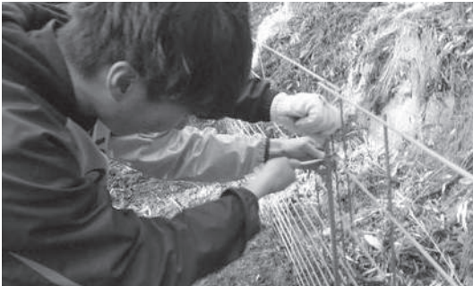
ワイヤーメッシュの設置作業
